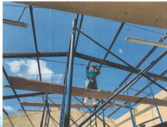
Foto 2: Mejoramiento de estructura de techo y cubierta de lamina troquelada calibre NO.26
